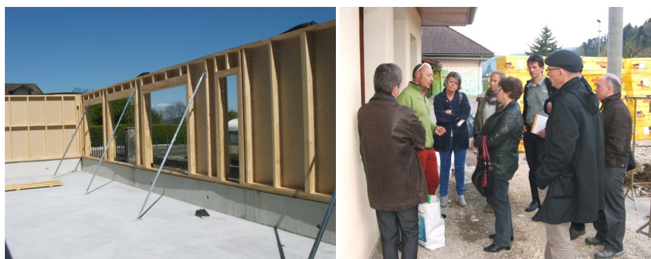
L'équipe municipale en réunion de chantier en présence de l'architecte Mr BAUQUIER Eric.
